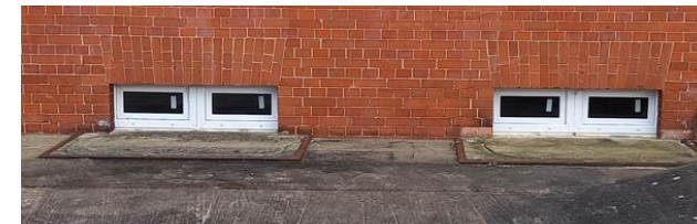
Einbau von 4 Kellerfenstern
