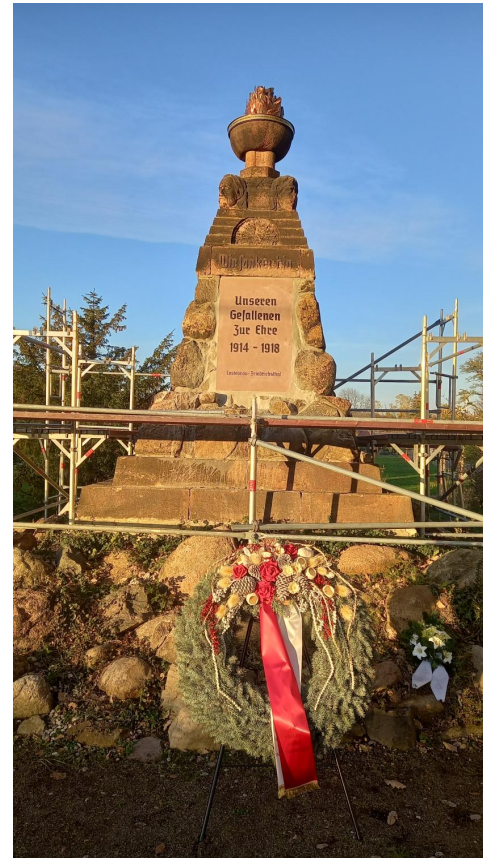
Sanierung Denkmal 1.WK 1.Sanierungsabschnitt
